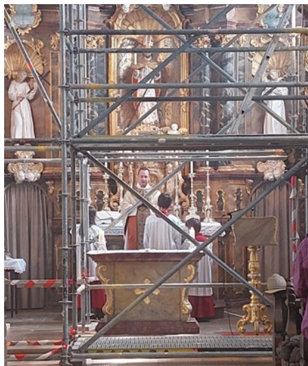
St. Blasius mit Baugerüst
